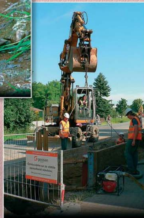
Kanalizace na P. N. Vsi
