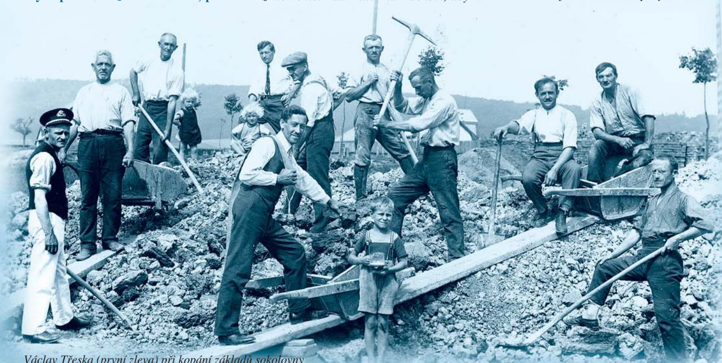
Václav Třeska (první zleva) při kopání základů sokolovny
