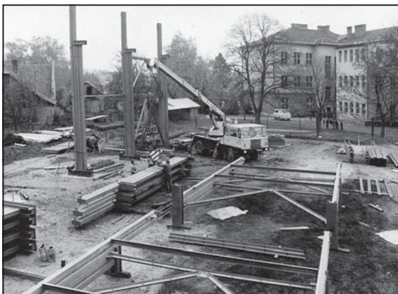
Stavba sportovní haly
