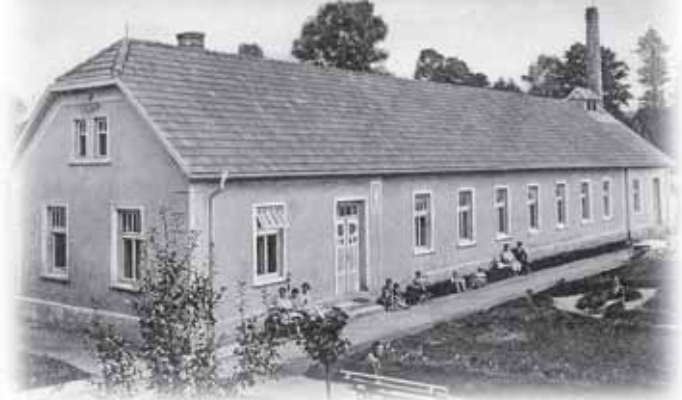
Vodoléčebný pavilon Kleplových lázní
