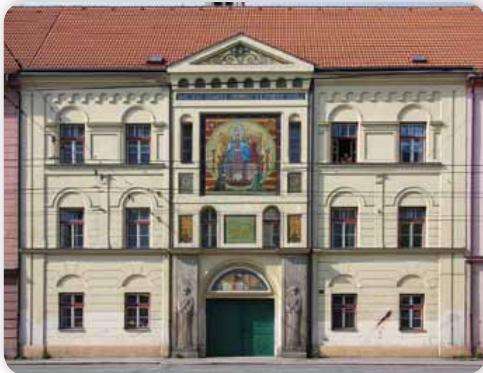
Průčelí kláštera petrinů v jehož dvoře stojí kostel Panny Marie Růžencové
