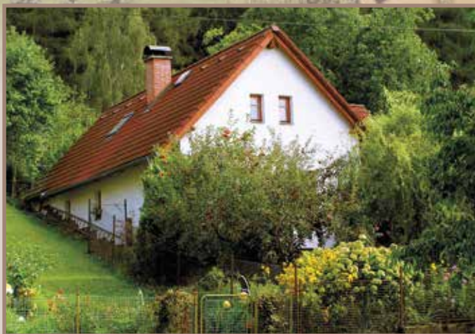
Brtev čp. 44 – současný stav
