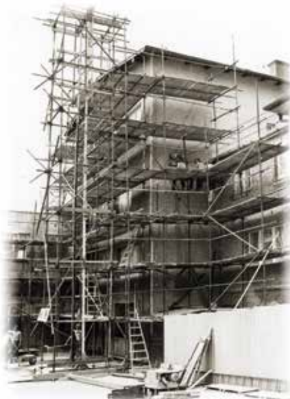
Přestavbu a nové prostory v Kotykově mlýně budovali zedničtí učni místního učiliště
