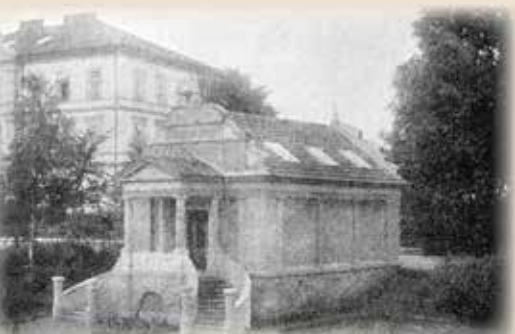
▲ Museum po dokončení stavebních prací v roce 1904 Postup prací na stavbě muzea, foto: Pižl, 1903 ▶
