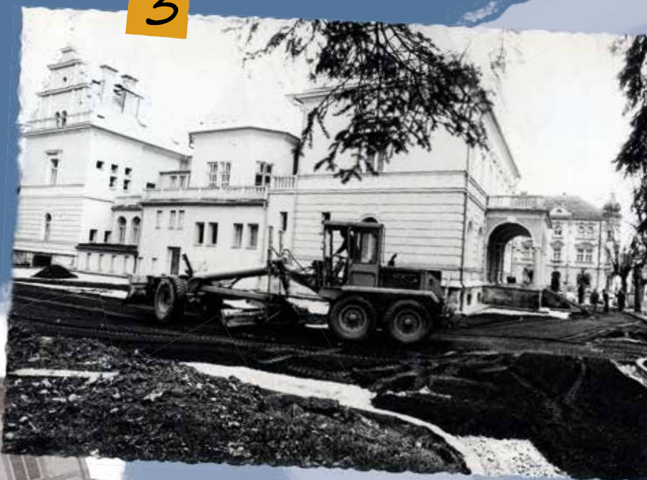
Asfaltování parkoviště v roce 1980
